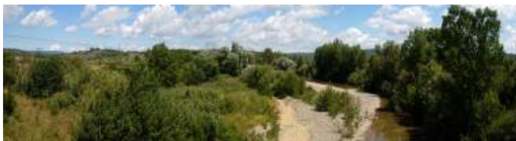
Fig. 4.30 - Evidenza di ricalibratura recente presso il ponte sul f. Cornia della S.R. 398 (foto G. Gusmaroli).
