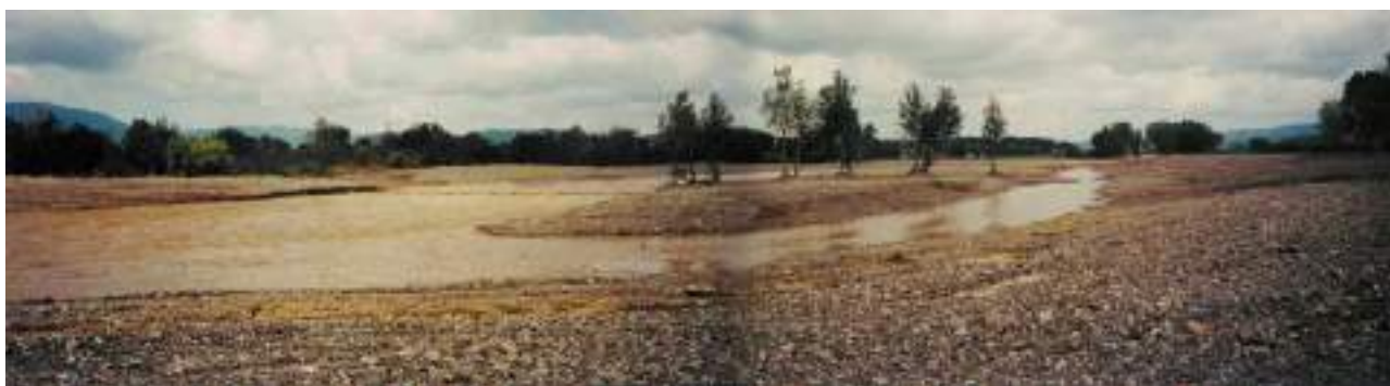
Fig. 4.27 - Intervento di ricalibratura in loc. Forni tra il guado di Forni e il guado Vivalda a inizio '00 (fonte CdB Toscana Costa).
