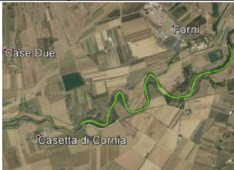
Fig. 3.23 – tratto CO_CO_3.01 (f. Cornia), fuori scala (ns elaborazione su ortofoto 2013 da Google Earth).
